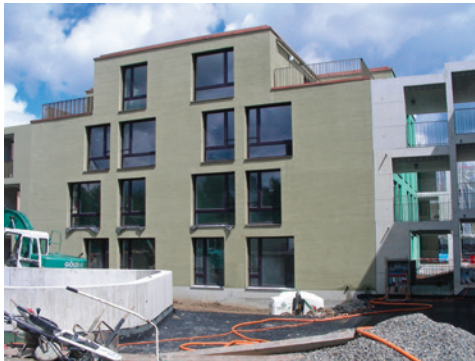
andante wird ab Oktober 2014 das Parterre und den ersten Stock dieses Hauses bewohnen. Im Vordergrund entsteht der Gartensitzplatz... (Bilder von Mitte Juli 14)
