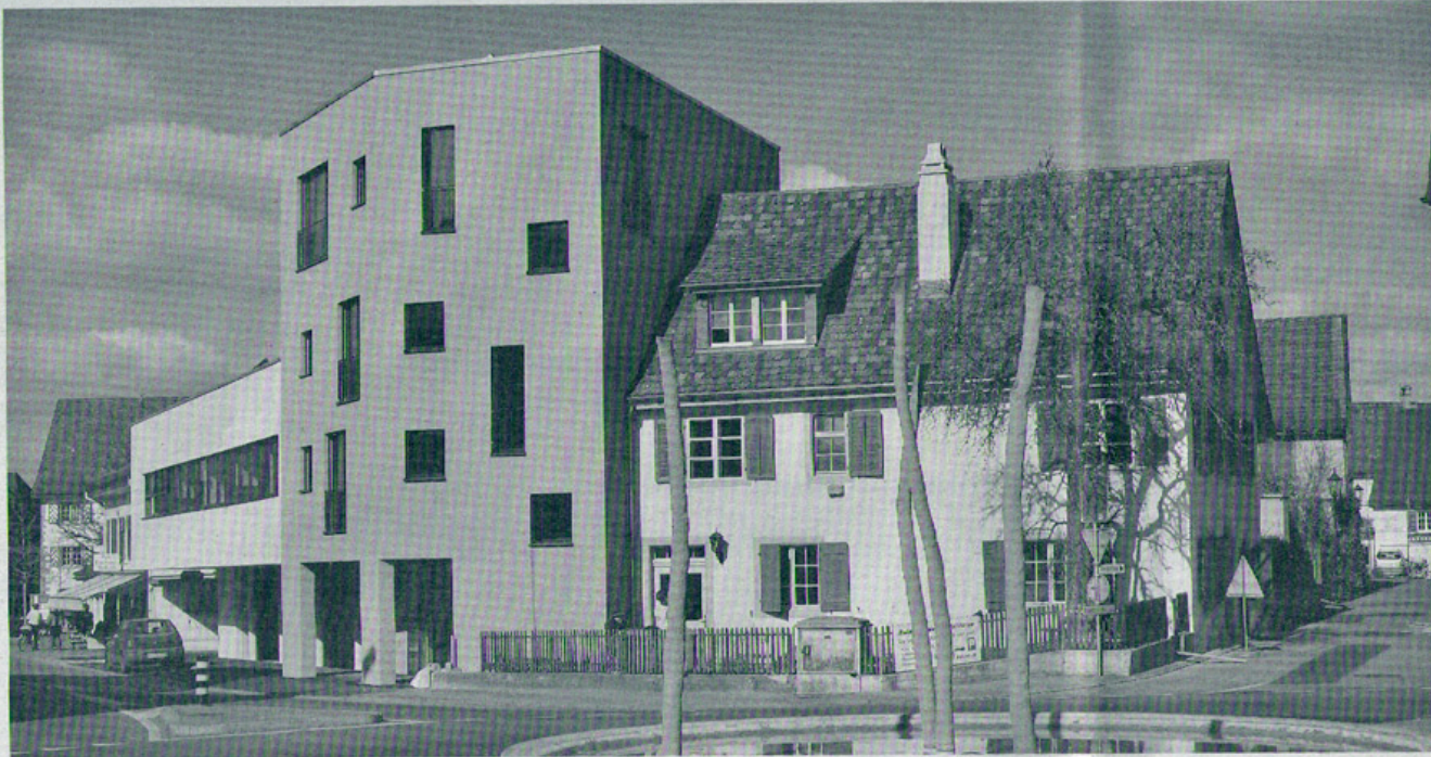
Der Neubau ist verbunden mit der «alten Schmiede» und kombiniert so Altes mit Neuem.
