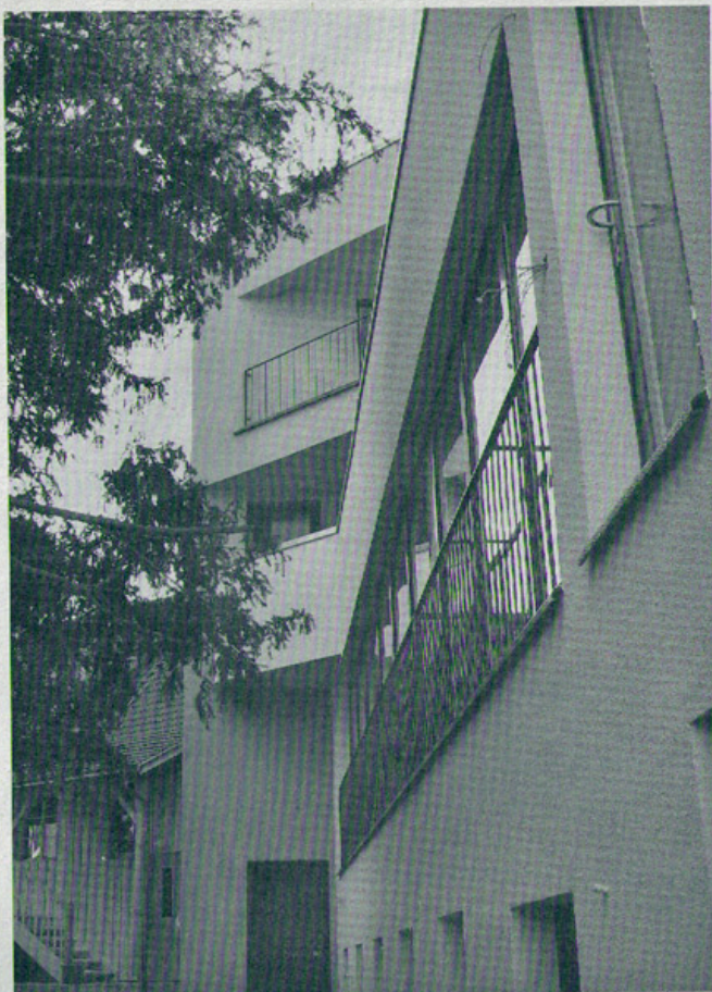
Die Hinteransicht vom Garten: Links Administration und Gemeinschaftsräume im Altbau, rechts die Wohnräume mit Balkon der Aussenwohngruppe.
